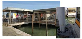
●ベネチアは、干満差が1mもないため、水上バスの 桟橋は2段階で、先端となるバス停コンテナだけ上下 するようになっている。
