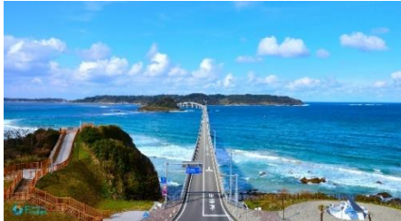
山口県：角島大橋
