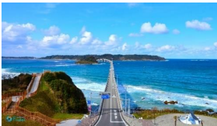
山口県：角島大橋
